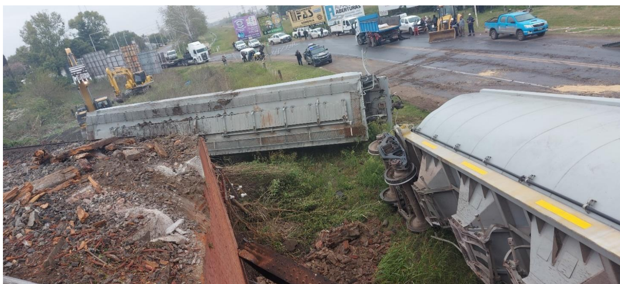
Figura 9. Vagones caídos sobre la sección sur del puente. Fuente: JST, 2022
