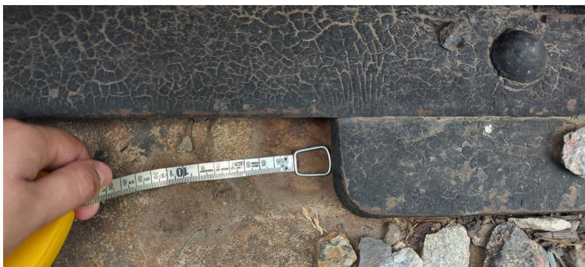
Figura 6. Medición del desplazamiento de la estructura del puente. Fuente: JST, 2022
