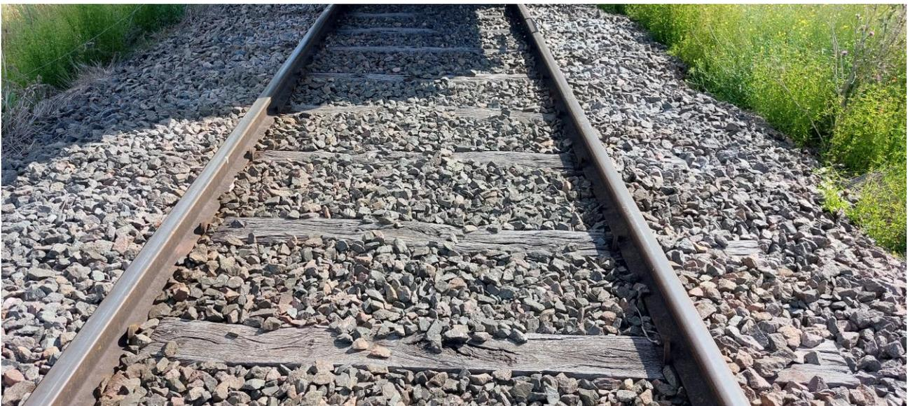
Figura 7. Superestructura de vía previa al lugar del descarrilamiento. Fuente: Archivo JST
