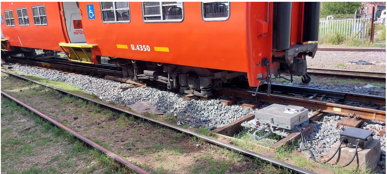
Figura 2. Bogie descarrilado del coche U.4350 sobre el ADV 26 y la vía principal descendente. Fuente: JST, 2022
