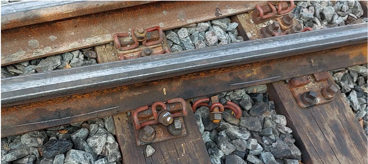
Figura 6. Marca del paso de la pestaña sobre el patín de riel. Fuente: JST, 2022
