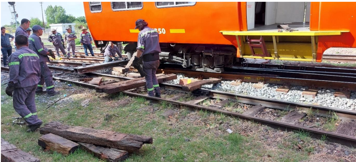
Figura 9. Tareas de encarrilamiento del coche U.4350. Fuente: JST, 2022
