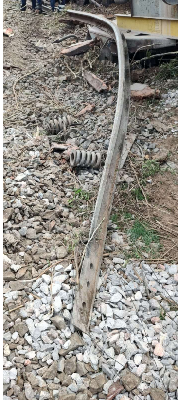
Figura 3. Aguja del aparato de vía a metros de la zona donde ocurrió el accidente. Fuente: JST, 2022
