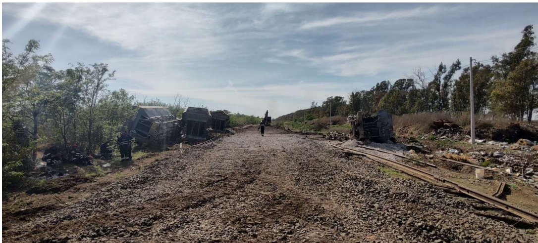
Figura 4. Superestructura de vía en proceso de reparación. Fuente: JST, 2022
