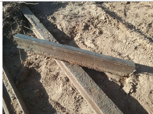
Fig. 4. Riel fracturado en el lugar del suceso
