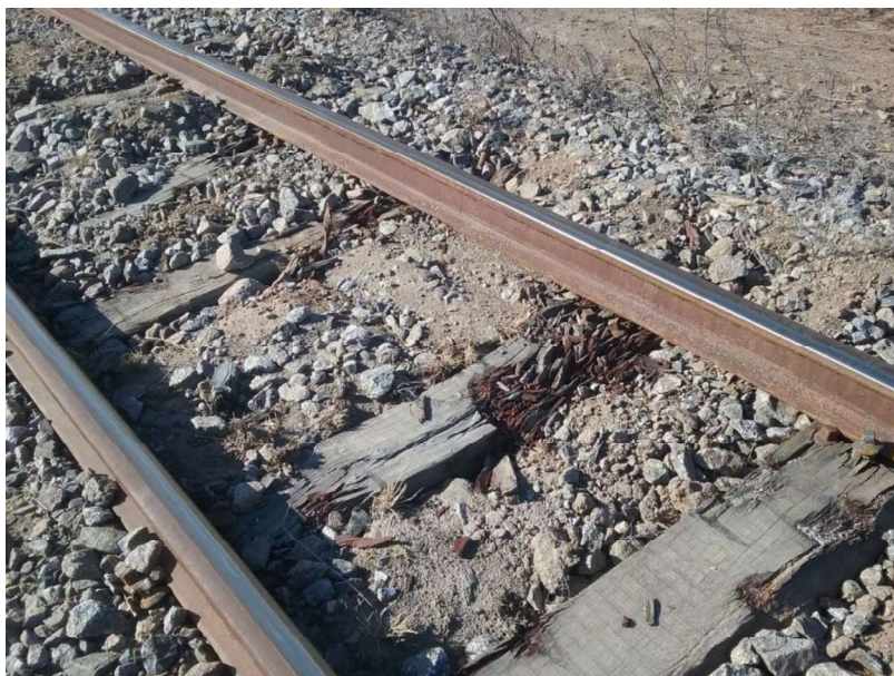
Figura 5. Durmientes partidos y marcados metros antes del lugar del suceso. Fuente: JST, 2022
