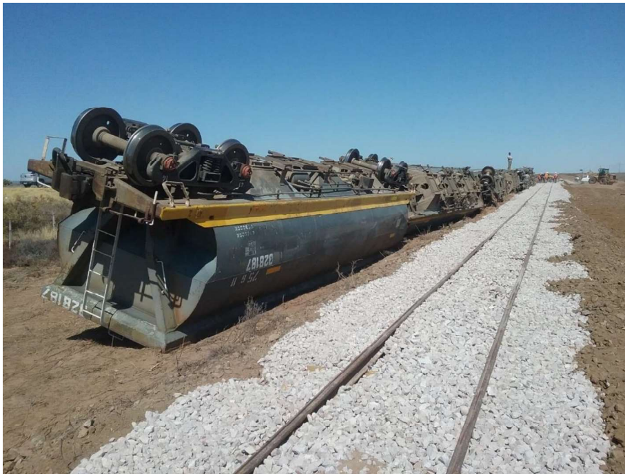
Figura 3. Vista de los vagones descarrilados y volcados hacia la izquierda, en sentido de la marcha del tren. Fuente: JST, 2022
