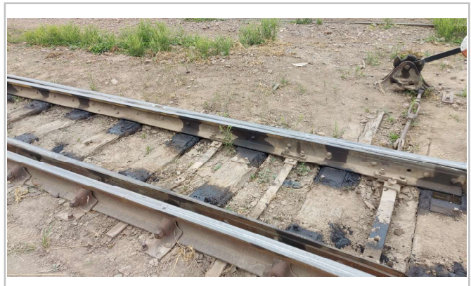
Figura 4. Cambio de vía de la estación Güemes
