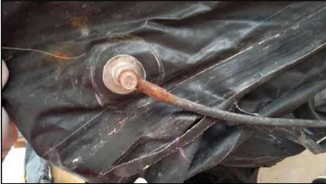
Figura 6. Inspección visual, estado del material.
