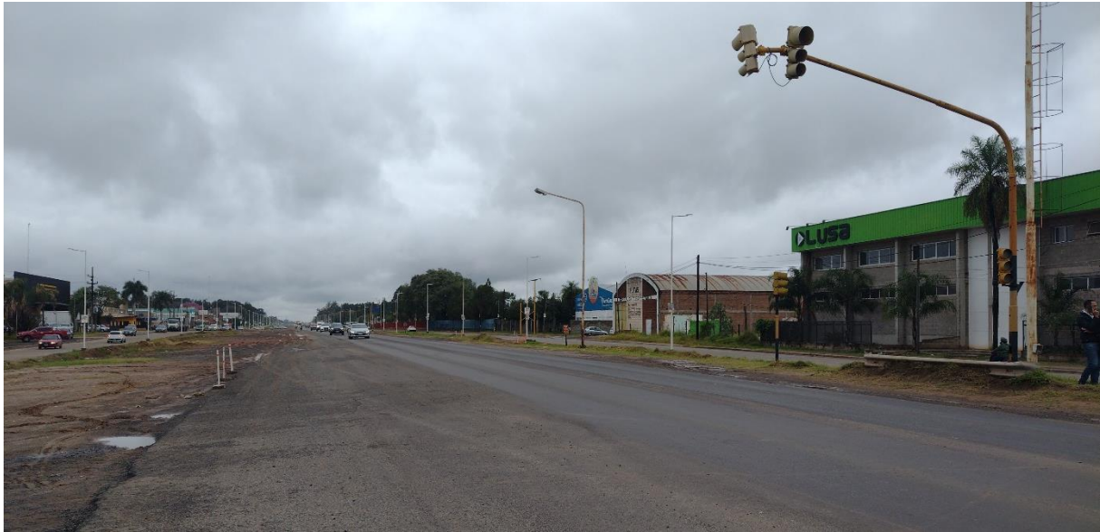
Figura 5. Vista del tramo de la ruta donde ocurrió el suceso, desde la intersección entre la vía colectora oeste y la Avenida Juan Domingo Perón. La fotografía fue registrada siguiendo el sentido de la ruta hacia el acceso sur de la ciudad. Fuente: JST, 2023
