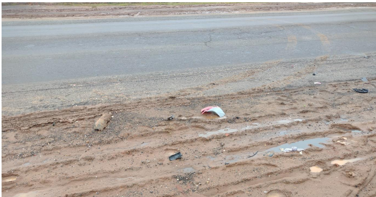
Figura 13. Restos materiales observados sobre la banquina contigua al carril descendente de la Ruta Nacional 12. Fuente: JST, 2023
