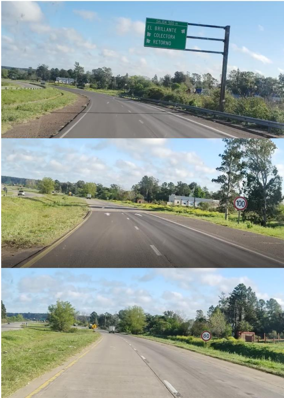
Figura 3. Vista de la calzada con sentido hacia El Palmar, donde puede observarse el cambio del material de la superficie. Además, señalización horizontal y vertical. Fuente: JST, 2023
