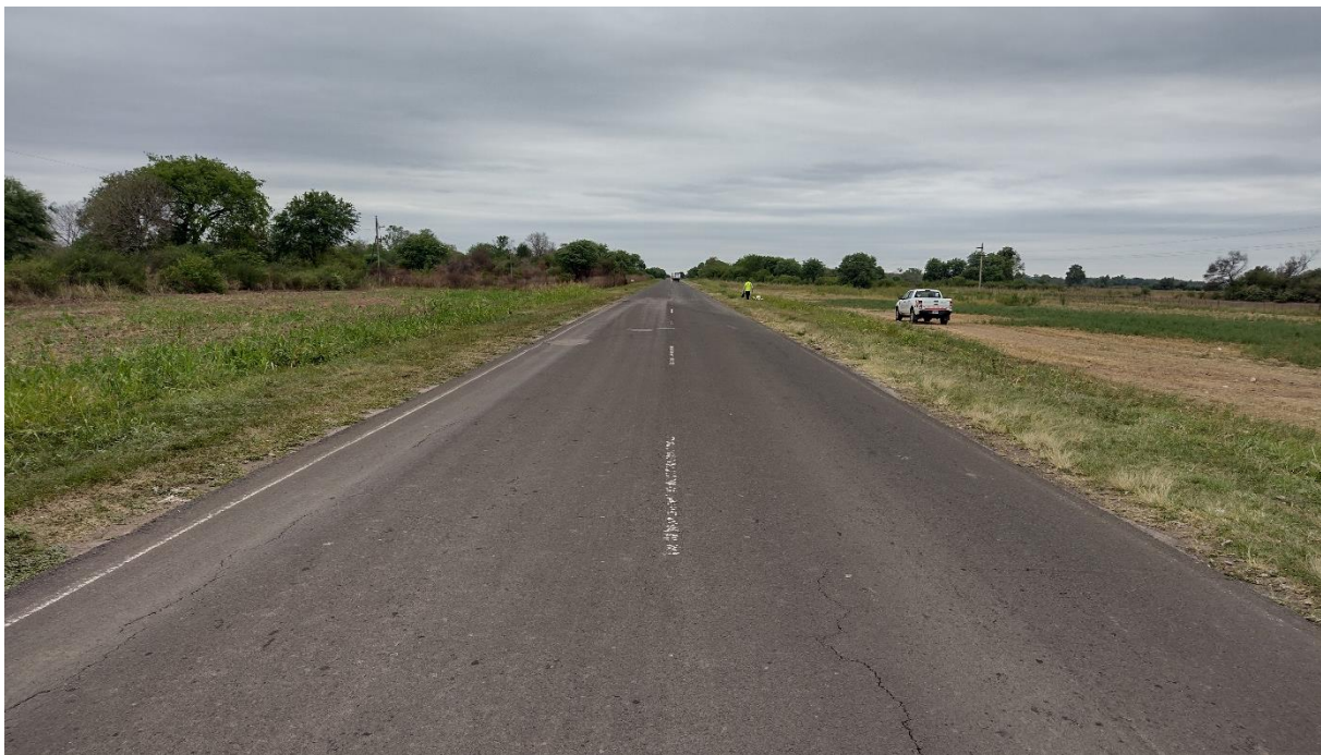
Figura 4. Vista del trayecto de la Ruta Nacional 95 en el sector donde se desarrolló la colisión. La imagen fue capturada siguiendo el avance hacia la ciudad de Presidencia Roque Sáenz Peña.
