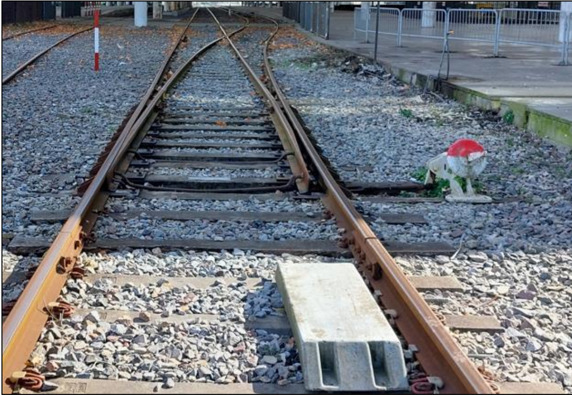
Figura 2. ADV donde se produjo el suceso. Fuente: JST, 2024
