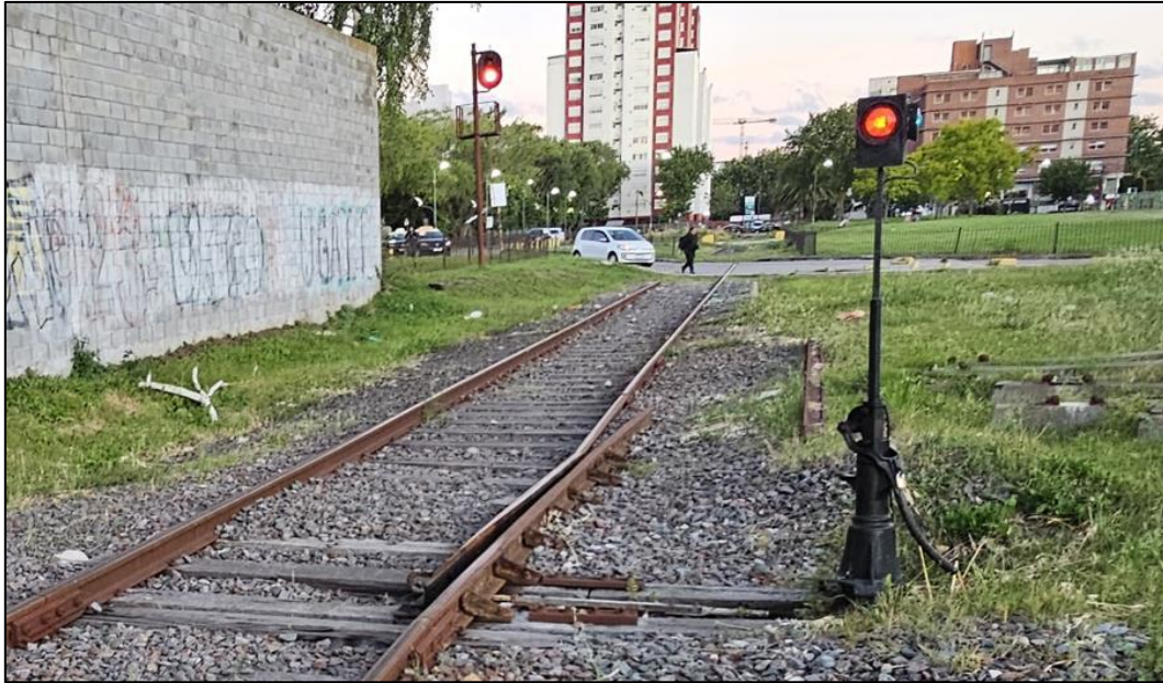
Figura 6. Vista de la trampa y su indicación en sentido ascendente. Fuente: JST, 2024
