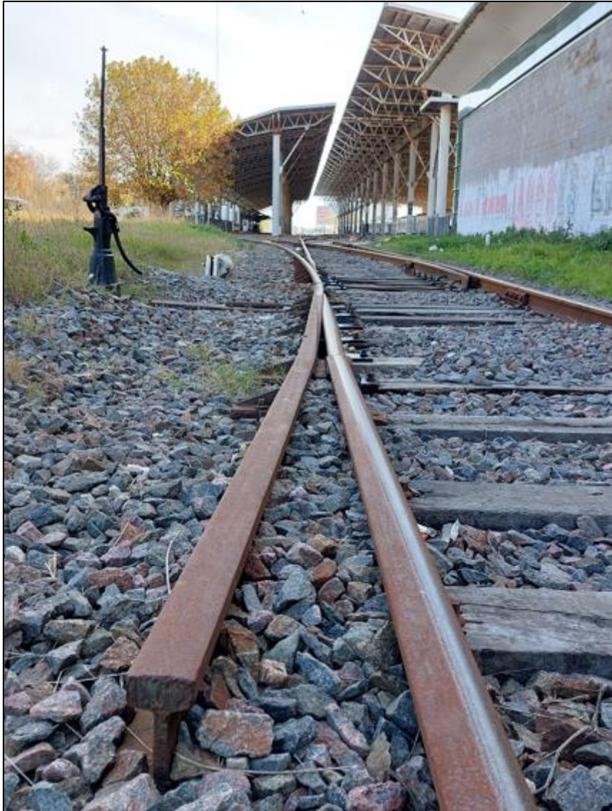
Figura 5. Vista de la trampa y su indicación en sentido descendente. Fuente: JST, 2024
