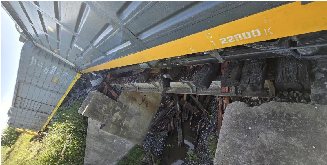
Figura 4. Vagón descarrilado sobre una alcantarilla. Fuente: JST, 2024
