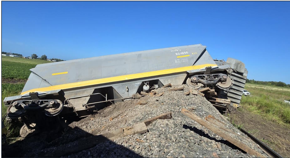
Figura 5. Bogies descarrilados del vagón 824656. Fuente: JST, 2024
