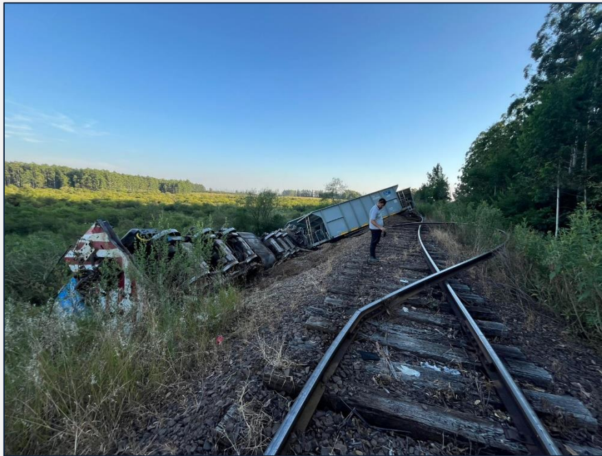
Figura 2. Locomotora, vagones descarrilados y deformación de rieles. Fuente: JST, 2024
