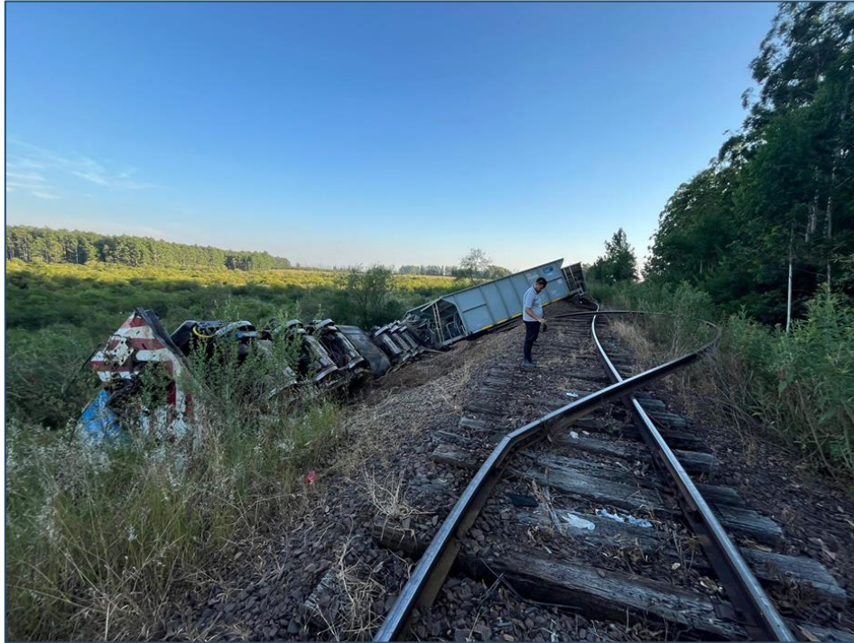
Figura 5. Daños de las instalaciones fijas. Fuente: JST, 2024
