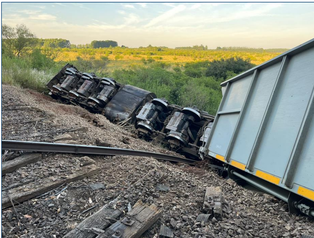
Figura 1. En la imagen se observa a la locomotora y a un vagón descarrilado del tren 08, junto con los daños en la superestructura. Fuente: JST, 2024
