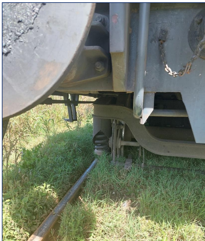
Figura 2. Vista de la rueda derecha del primer coche del tren FU 2567 en el sentido de circulación.
