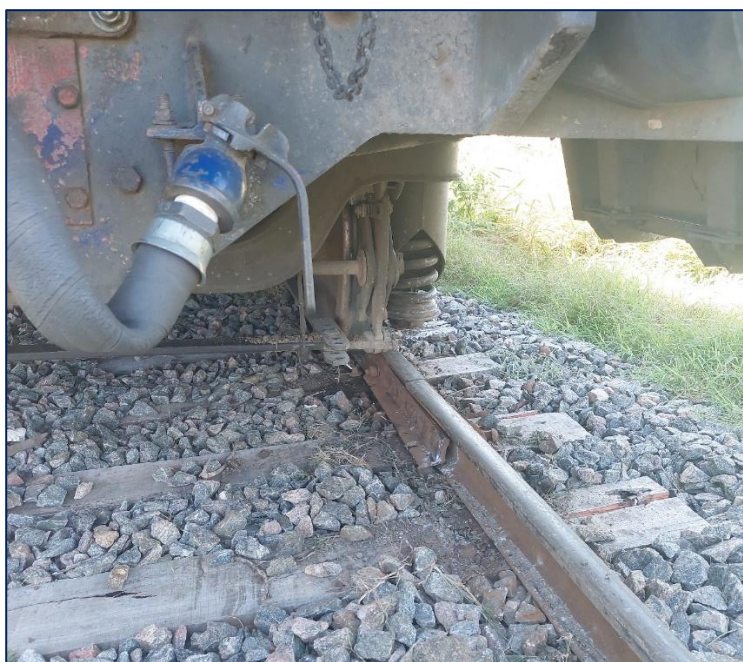
Figura 3. Vista de la última rueda descarrilada del lado derecho en el sentido de marcha.
