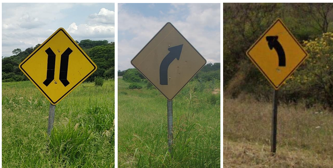
Figura 6. Señalización vertical constatada en el lugar del suceso. De izquierda a derecha: “Puente angosto”, “Curva amplia hacia la derecha” y “Curva amplia hacia la izquierda”. Fuente: JST, 2024
