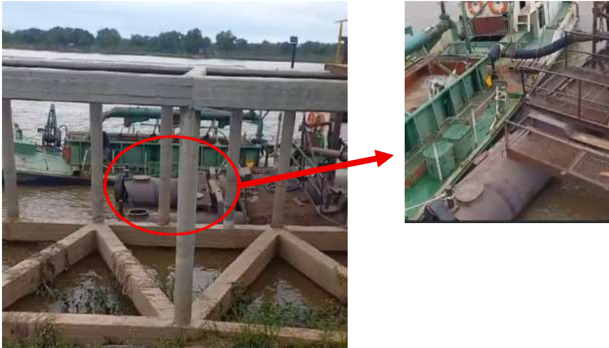
Figura 12. Muelle donde ocurrió el suceso. Se observa un pontón flotante y una estructura de hormigón sobre la costa para facilitar el atraque y la conexión del manguerote para la descarga
