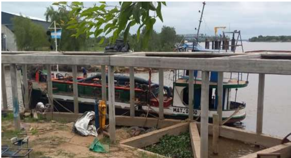
Figura 4. B/M María del Carmen amarrado en el muelle donde ocurrió el suceso. Vista de la banda de babor. Se observa en la costa una estructura de hormigón para facilitar el atraque del buque.
