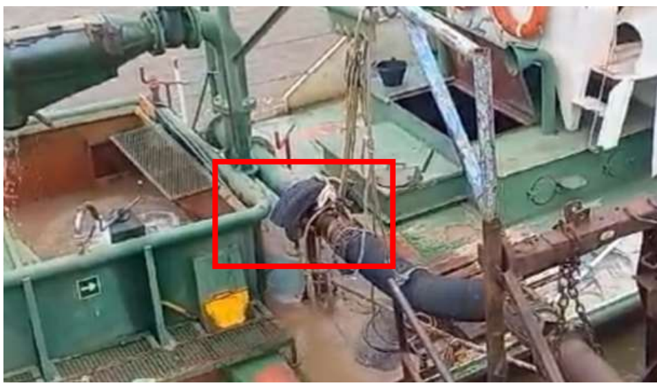
Figura 13. Conexión del manguerote para la descarga
