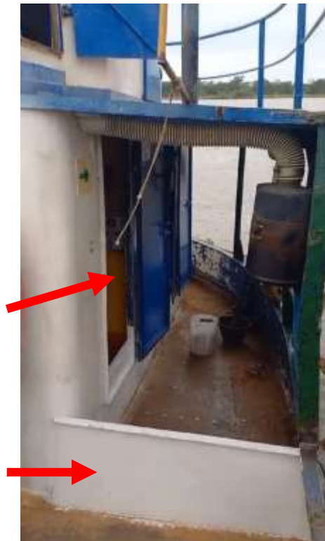
Figura 8. Se observa el pasillo por la banda de babor, se indican con flechas la puerta de acceso a la sala de máquinas abierta y el umbral que se construyó luego del suceso, este divide la parte de popa de la cubierta principal (hacia donde está la puerta de acceso a SSMM) con el sector donde está la pileta de carga (parte inferior de la foto).
