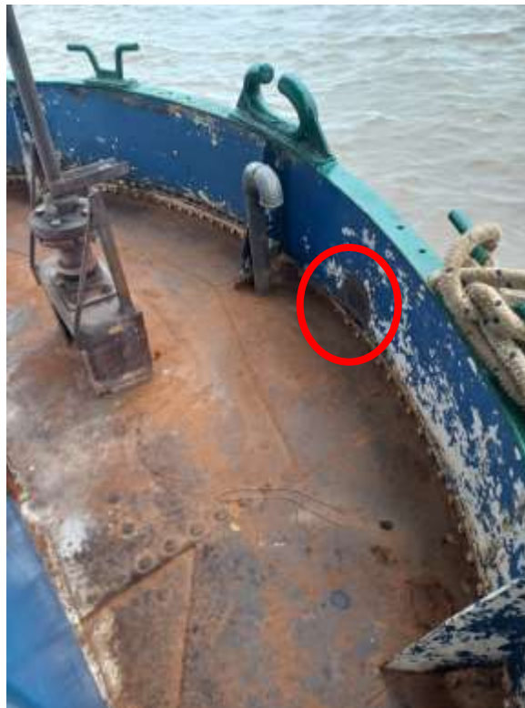
Figura 11. Se observa un desagüe clausurado en la popa. Estaba abierto al momento del suceso.
