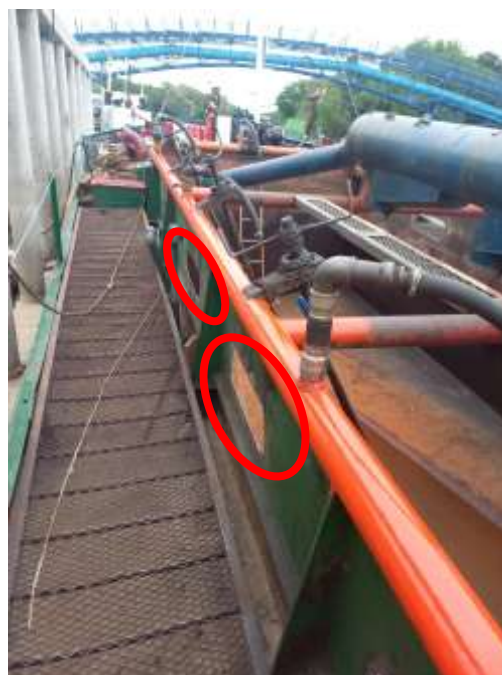
Figura 10. Se observan dos de las cuatro bocas de descarga de la pileta de la banda de babor. Al momento del hundimiento se encontraban obturadas.
