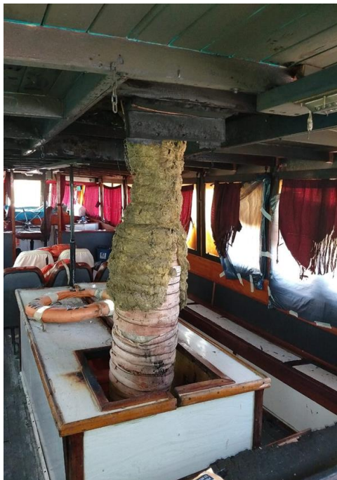
Figura 11. Foto del interior de la lancha luego del incendio. Se observa el sistema de exhaustación recubierto de material aislante y la destrucción total de la cobertura de madera.
