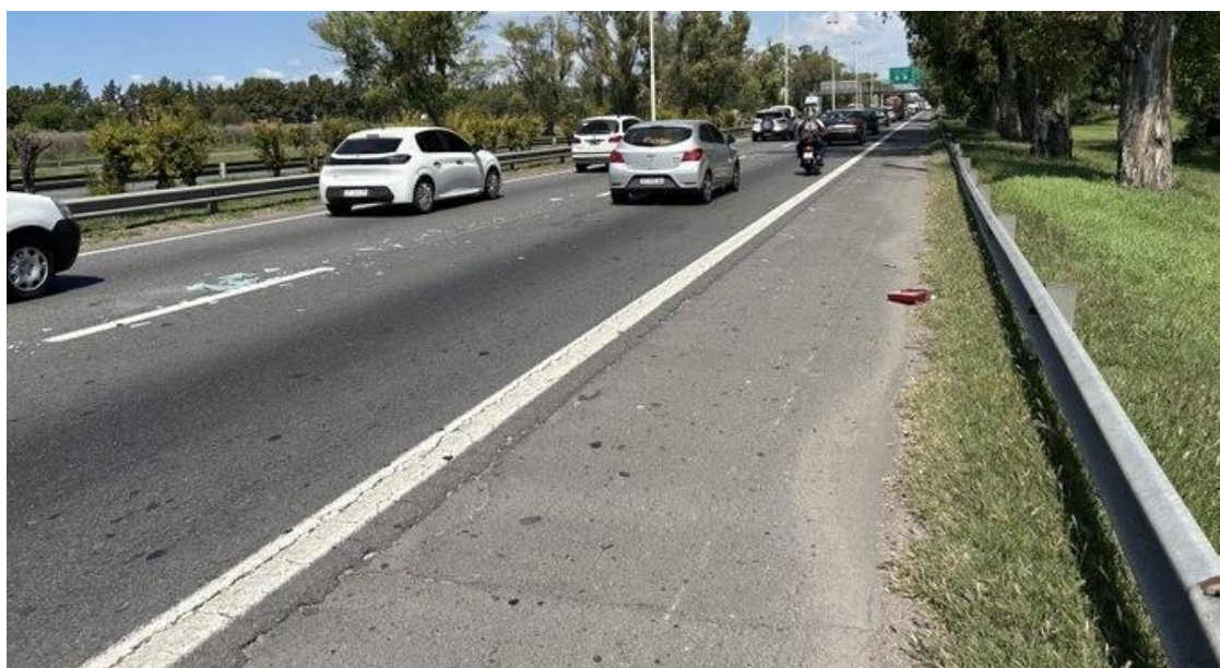
Figura 3. Vista de la vía en la zona del suceso. Fuente: JST, 2024
