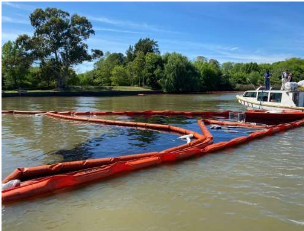
Figura 19. Contención de la mancha con barreras flotantes el día del reflotamiento del Rúa II
