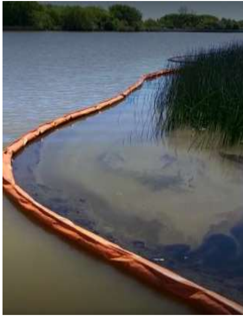
Figura 17. Barrera flotante de contención para hidrocarburos
