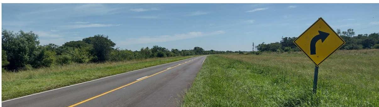
Figura 5. Señal vertical de curva ubicada de forma previa al lugar de ocurrencia del suceso. Fuente: JST, 2024
