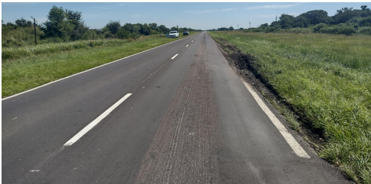
Figura 9. En la imagen se indica el lugar de la vía donde el Vehículo 1 comenzó el despiste al contactar la banquina ubicada a la derecha del conductor. Fuente: JST, 2024
