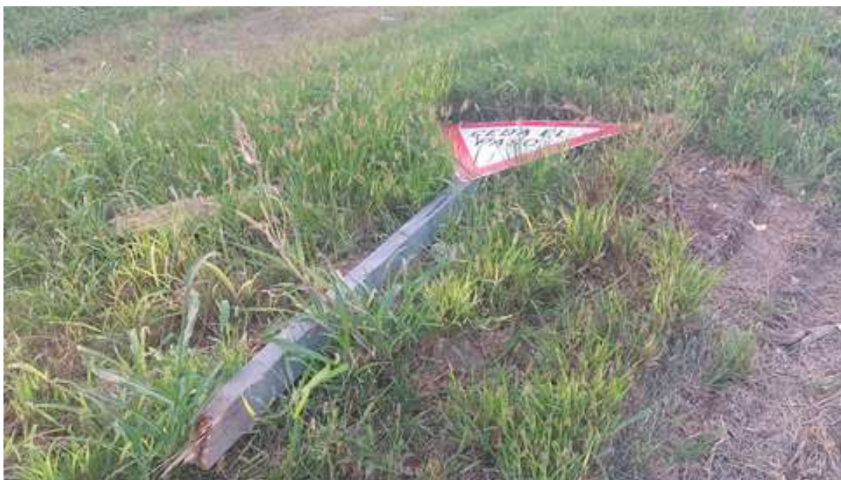
Figura 4. Señal dañada ubicada en la banquina. Fuente: JST, 2024
