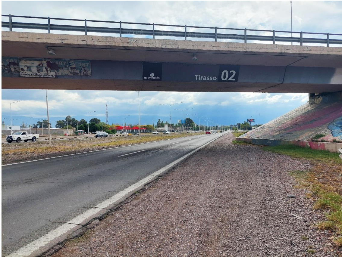
Figura 2. Fotografía general del lugar del suceso en la Ruta Nacional 7 donde puede observarse el puente Tirasso, con vista de este a oeste, hacia la Ciudad de Mendoza. Fuente: JST, 2024
