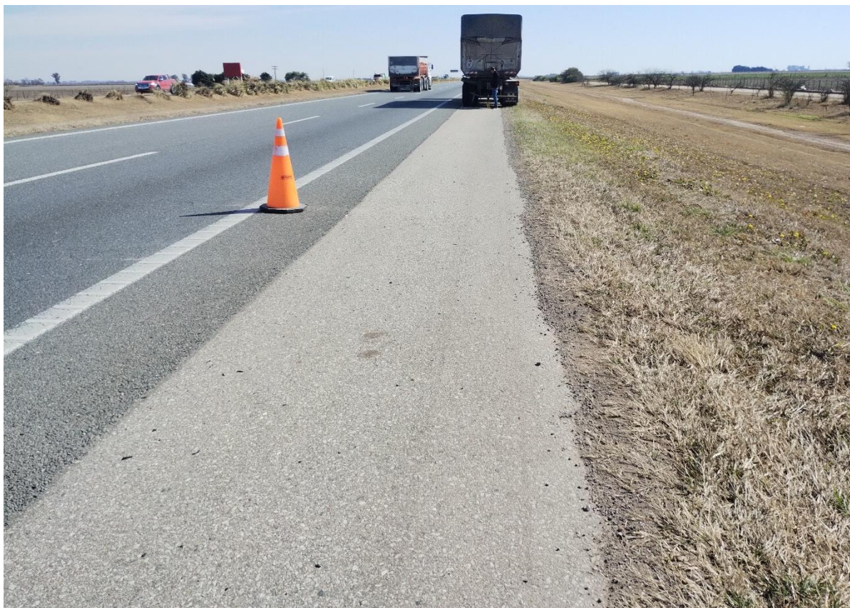
Figura 12. Posición final del Vehículo 1 sobre la banquina. Fuente: JST, 2024
