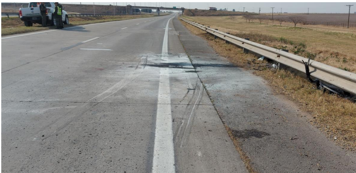
Figura 10. Marcas de neumático y fluido dinámico en sentido de marcha y estático, que indican la posición final de los vehículos. Se observa residuo blancuzco proveniente de extintor. Vista hacia Correa. Fuente: JST, 2024
