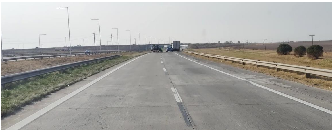
Figura 4. Vista hacia Correa. Señalización horizontal en el lugar del suceso y barreras de contención semirrígidas. Se observa la finalización de la barrera semirrígida de la banquina interna. Fuente: JST, 2024
