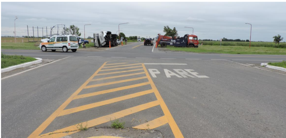
Figura 5. Reducción de ancho de calzada. Vista desde Bernardo de Irigoyen hacia la intersección.
