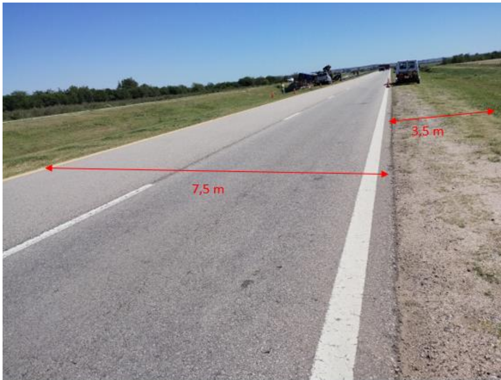
Figura 3. Medidas y características de la vía donde ocurrió el suceso. Fuente: JST, 2023
