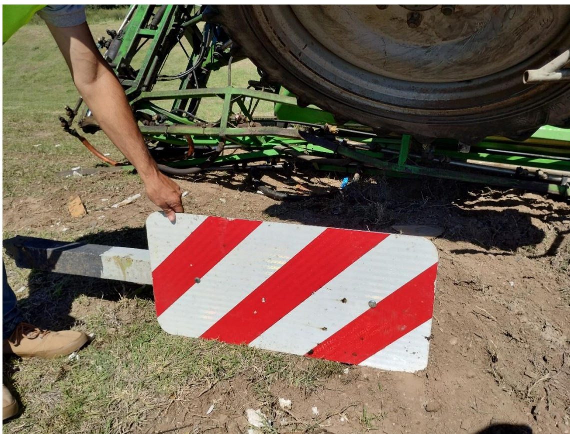
Figura 5. Panel de prevención (obstáculo rígido) desplazado de su ubicación a causa de la colisión.
