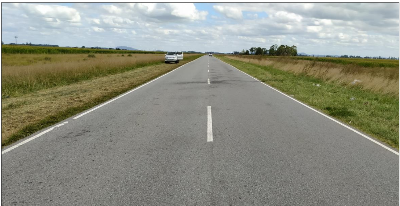
Figura 2. Fotografía de la vía en el lugar del suceso, vista hacia Tandil. Fuente: JST, 2021.
