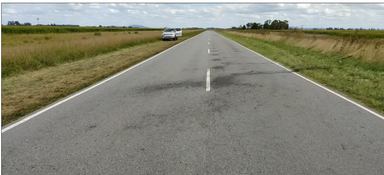
Figura 5. Imagen del lugar del suceso, con vista hacia la ciudad de Tandil. La zona de colisión se ubica de forma previa al inicio de los rastros dinámicos de fluidos, a la izquierda de la fotografía, sobre el carril de circulación hacia la ciudad de Rauch. Fuente: JST, 2021.
