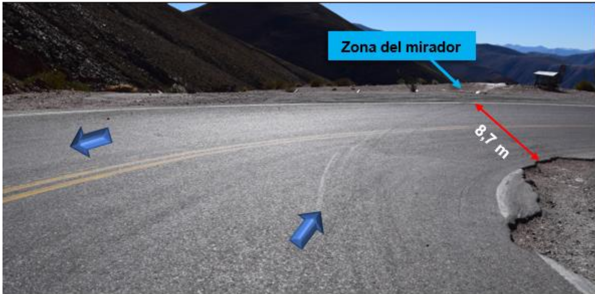
Figura 9. Dimensiones de calzada y banquetas del tramo curvo donde se produce el despiste
