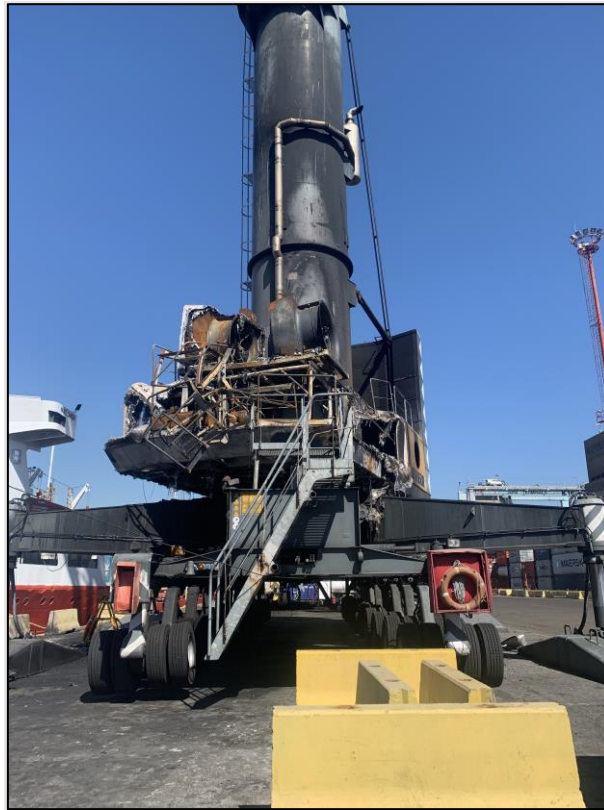
Figura 9. Vista de frente de los restos de la grúa incendiada. Fuente: JST, febrero de 2021
