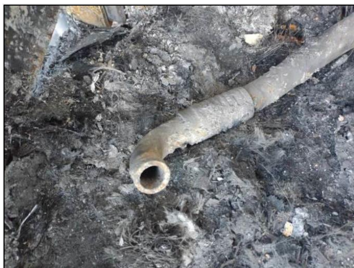
Figura 39. Manguera desprendida sin rastros de efectos térmicos. Fuente: Informe Técnico BV, 2021
