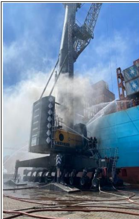
Figura 5. Grúa MHC 07 durante el suceso
