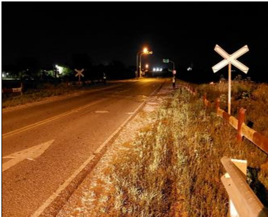
Figura 13. Vista del PAN en condiciones nocturnas (sentido este-oeste, dirección del minibús)
