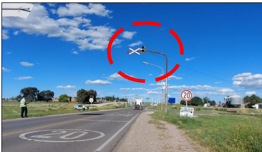
Figura 22. Ruta Provincial 67 en proximidad al PAN (sentido oeste-este). Puede apreciarse la señalización pasiva vertical en altura. Fuente: JST, 2021
