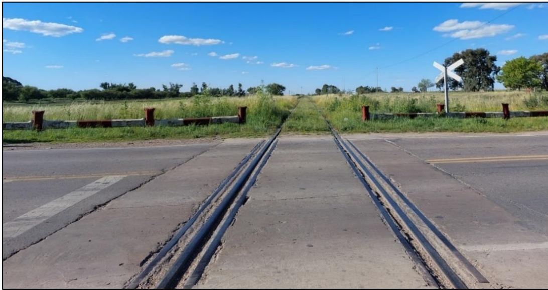
Figura 11. Vista de la traza ferroviaria en el PAN (en sentido de Bahía Blanca a Constitución)
