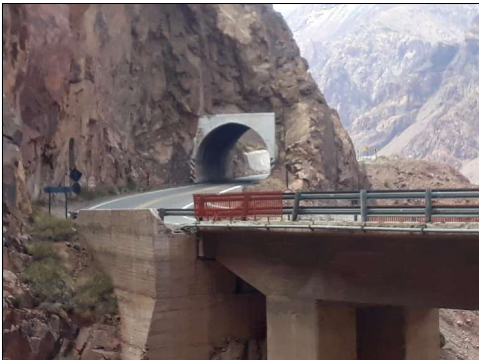
Figura 18. Fotografía panorámica desde el lado opuesto (en dirección) al de circulación del Vehículo 1. Obsérvese el cambio de pendiente desde la salida del túnel hasta el inicio del puente. Fuente: JST, 2021.
