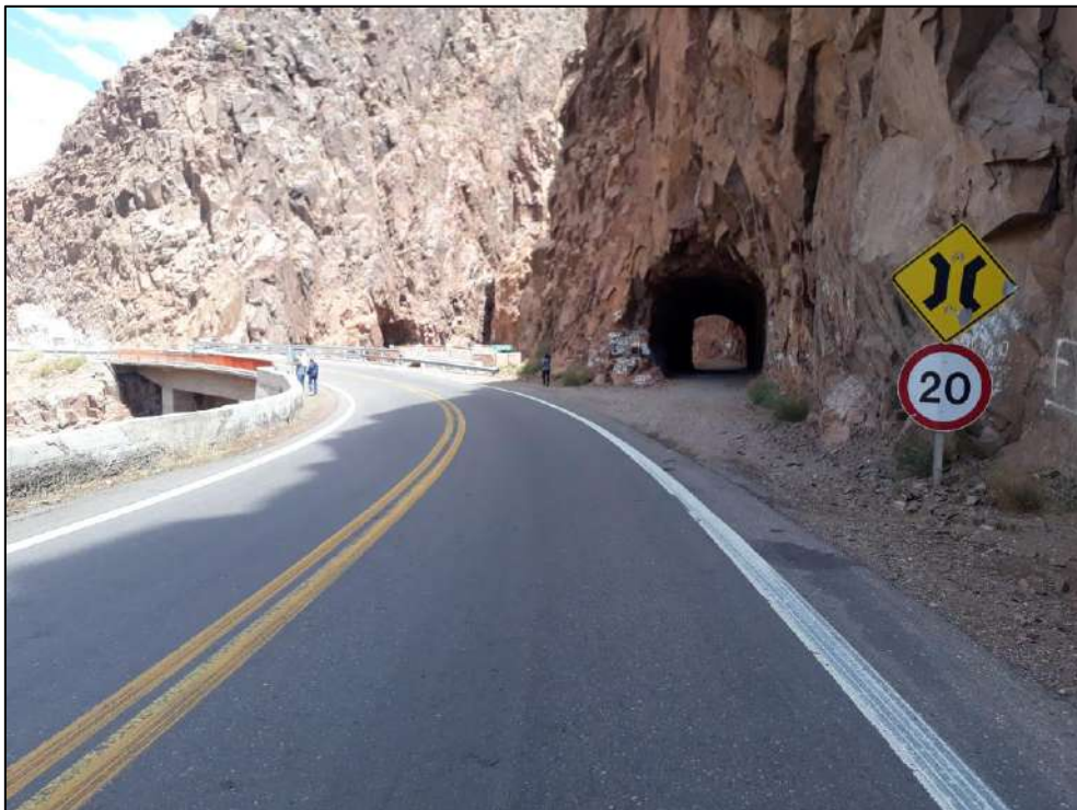
Figura 6. Panorámica desde la posición del conductor previo al lugar del accidente. Obsérvese señalización vertical a la derecha de la fotografía y viejo túnel de montaña. Fuente: JST, 2021.
