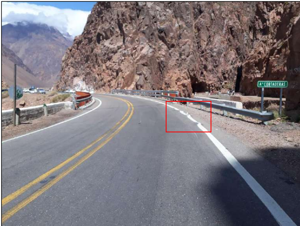
Figura 7. Panorámica desde la posición del conductor previo al lugar del accidente. Obsérvese el inicio del puente y las características de la vía, en especial las ondulaciones del borde externo derecho sobre línea blanca. Fuente: JST, 2021.
