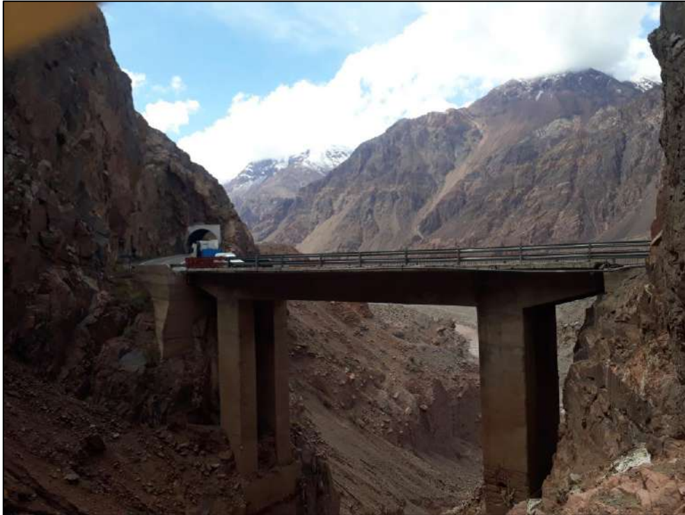
Figura 17. Fotografía panorámica desde el lado opuesto (en dirección) al de circulación del Vehículo 1. Obsérvese el puente y el barranco. Fuente: JST, 2021.
