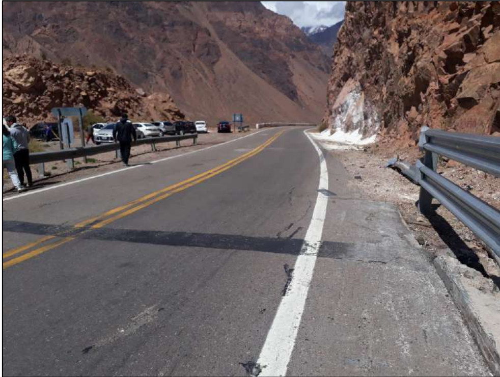
Figura 10. Panorámica del final del puente. Fuente: JST, 2021.
