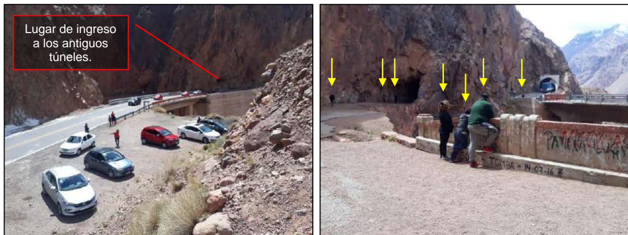
Figura 26. Fotografías de la presencia de turistas. Obsérvese el camino a recorrer a pie, desde el lugar de estacionamiento hasta el ingreso al viejo túnel. Con flechas verticales se señala la presencia de personas. Fuente: JST, 2021.
