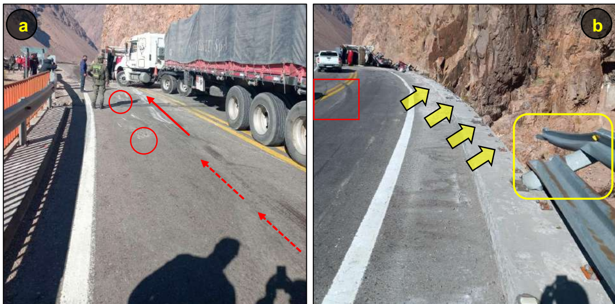
Figura 3. Fotografías del lugar del suceso: a) improntas neumáticas discontinuas, rotura de carpeta asfáltica y marcas de fricción, todas sobre la superficie del carril izquierdo (cardinal este, opuesto al de circulación); b) faltante de la defensa lateral derecha (oeste, en sentido de circulación) sobre el puente. También se logran visualizar improntas neumáticas curvas sobre la doble línea amarilla. Fuente: GUM Uspallata LH, 2021.
