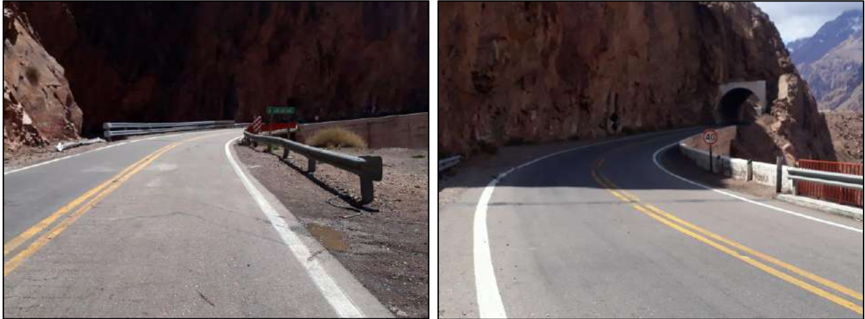
Figura 15. Panorámica desde el sentido de circulación opuesto al de la unidad en estudio. Obsérvese la señalización vertical. Fuente: JST.
