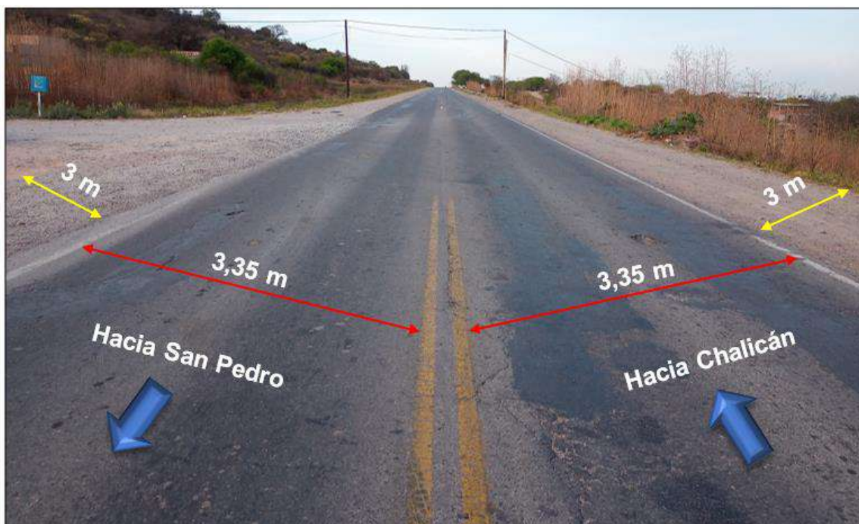
Figura 4. Fotografía con vista sur-norte donde se indican las dimensiones de calzada y banquina del sector de la ruta donde ocurrió el suceso. Fuente: JST, 2021.
