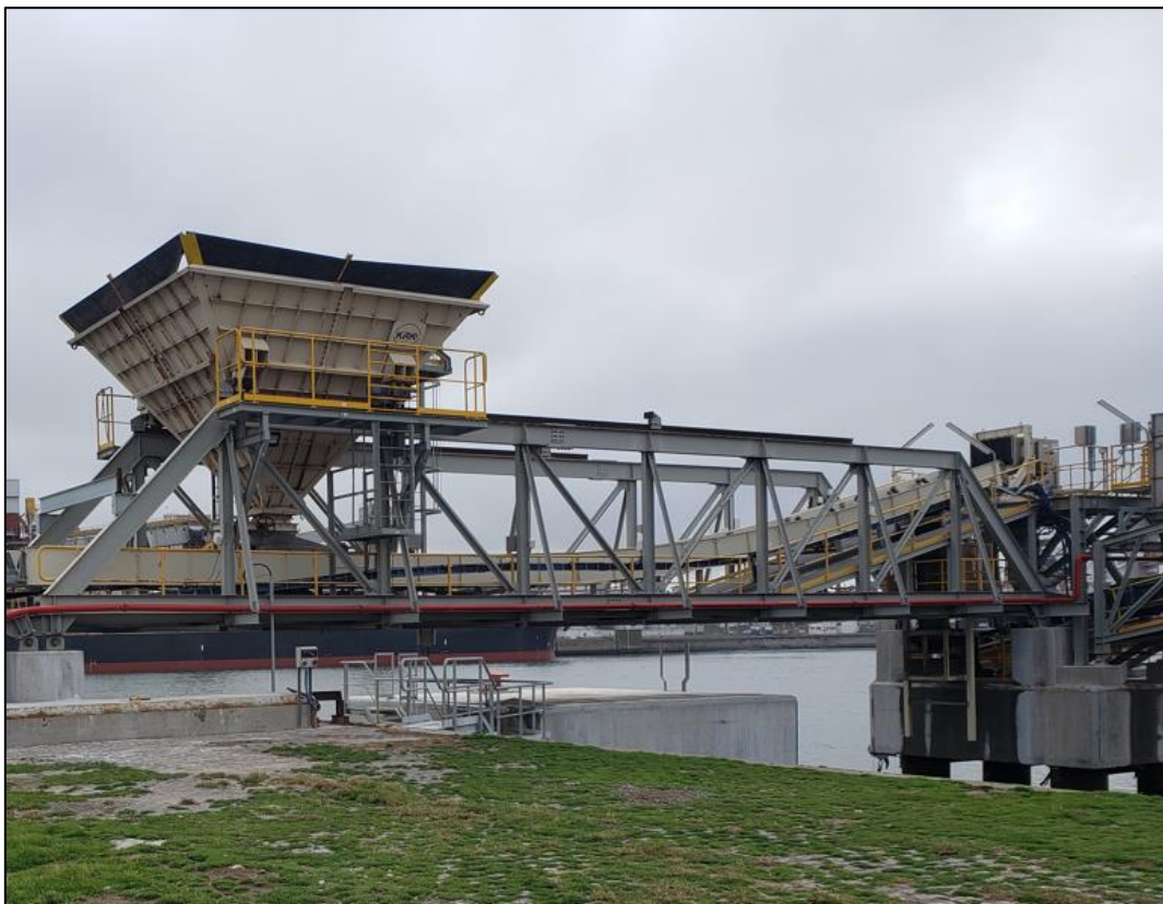
Figura 1. Galería de descarga, tolva y cinta transportadora
