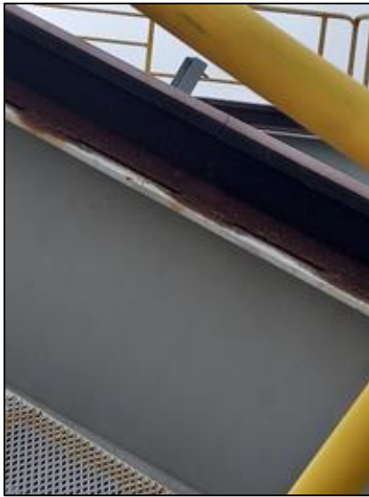
Figura 10. Fisuras y fractura del riel
