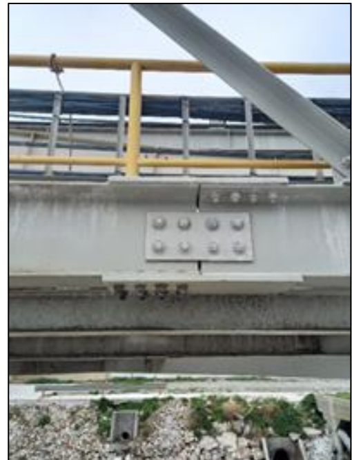
Figura 9. Unión de vigas de galería
