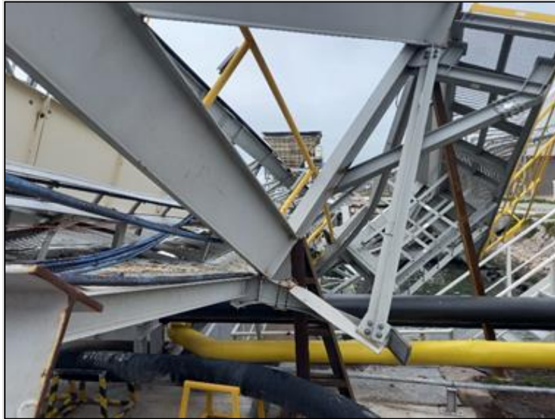
Figura 13. Apuntalamiento de la estructura
