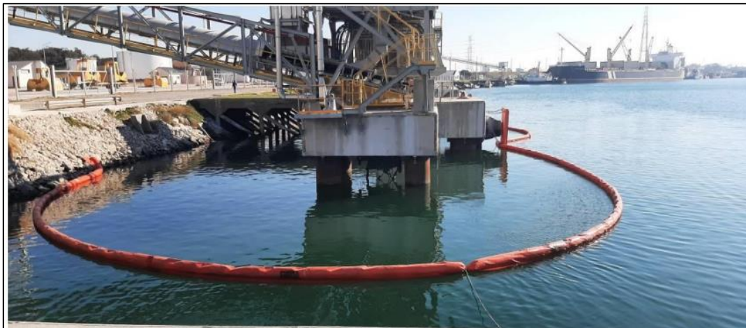
Figura 14. Barreras de contención
