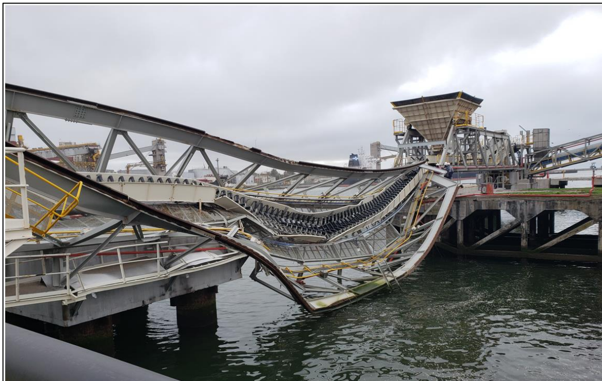
Figura 2. Galería colapsada
