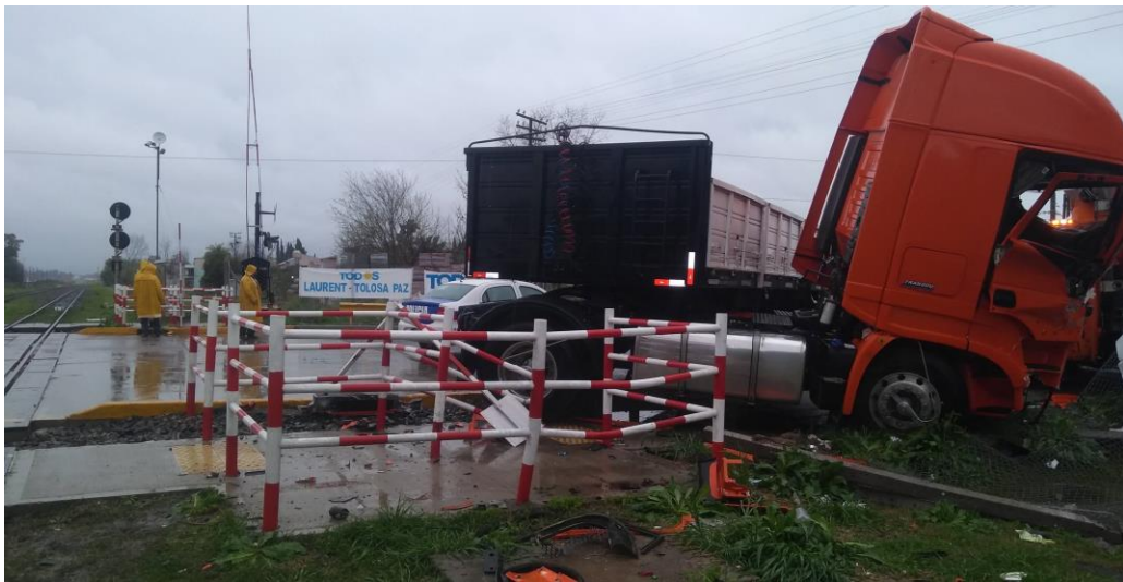
Figura 5. Imagen de laberinto peatonal vía ascendente, próximo a Estación Terminal Villa Rosa. Señalización pasiva y alambrado perimetral dañado.
