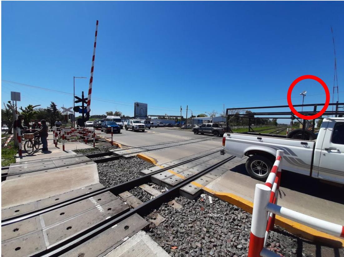
Figura 10. Ubicación de las tres cámaras, pertenecientes a Ferrovías S.A.C.
