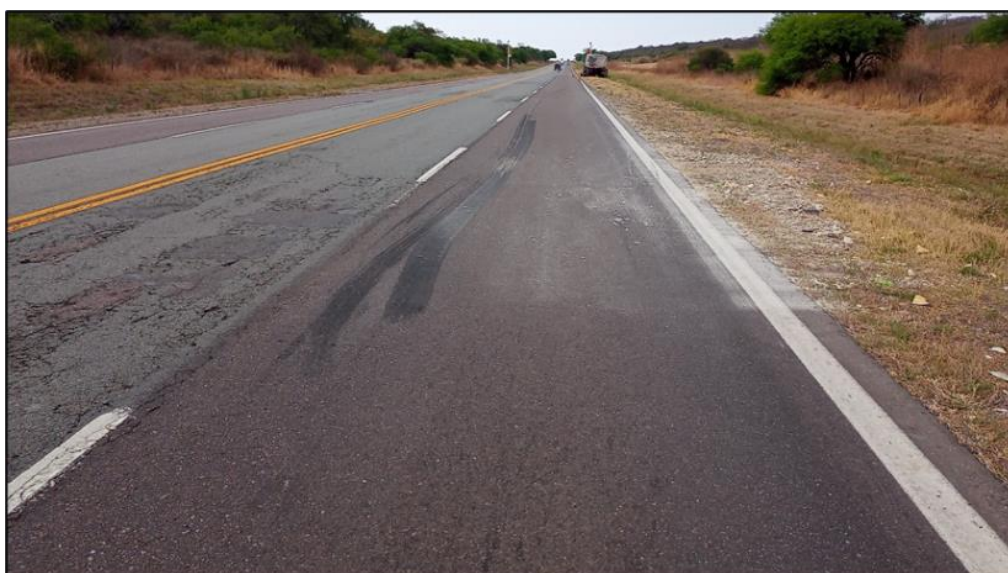
Figura 2. Fotografía con vista sur-norte de la ruta donde se observa la zona de impacto entre los vehículos sobre el carril derecho y la huella de neumático dejada por el semirremolque del camión. Fuente: JST.
