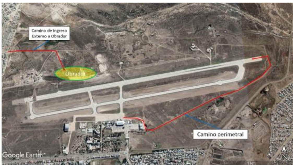
Figura 3 Caminos para transitar con vehículos de la obra
