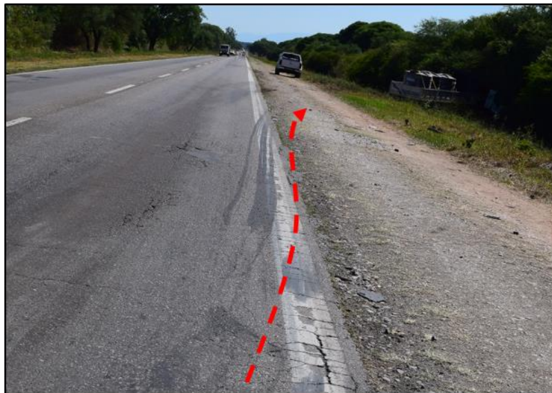
Figura 11. Fotografía de la huella de derrape demarcada por la rueda derecha del tractor del camión sobre la calzada luego de la colisión. Fuente: JST, 2021
