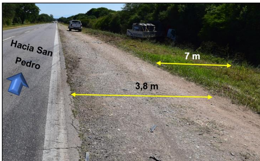
Figura 4. Dimensiones y características del costado este de la calzada. Fuente: JST, 2021.
