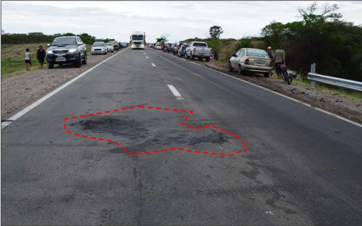
Figura 9. Restos de material incendiado sobre la calzada (posiblemente material de neumático), luego de la colisión. Fuente: JST, 2021.
