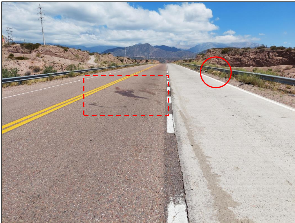
Figura 17. Posición final Vehículo 2. Se pueden observar manchas de fluidos vehiculares sobre el carril central y un perro muerto (dentro de un círculo) a la derecha de la imagen (banquina este). Fuente: JST, 2021.
