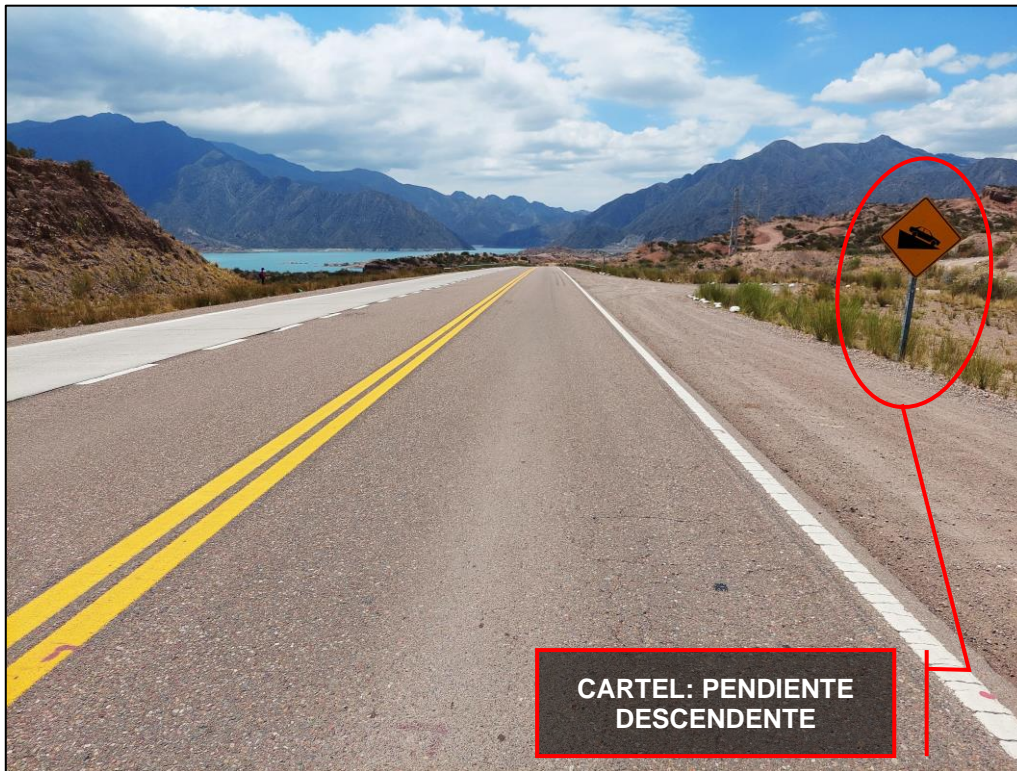
Figura 8. Vista panorámica desde el Vehículo 1. Señalización horizontal (doble línea amarilla y línea blanca continua externa de la calzada) y vertical preventiva (pendiente descendente) previo a la zona de impacto. Fuente: JST, 2021.
