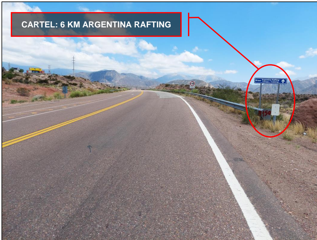
Figura 14. Vista panorámica desde el Vehículo 2. A la derecha de la imagen, una señal vertical informativa y, debajo de esta, el soporte de un panel preventivo (sin lámina). Fuente: JST, 2021.
