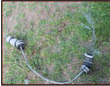
Figura 14. Segunda línea de canopy arrancada de la base de la rampa 3
