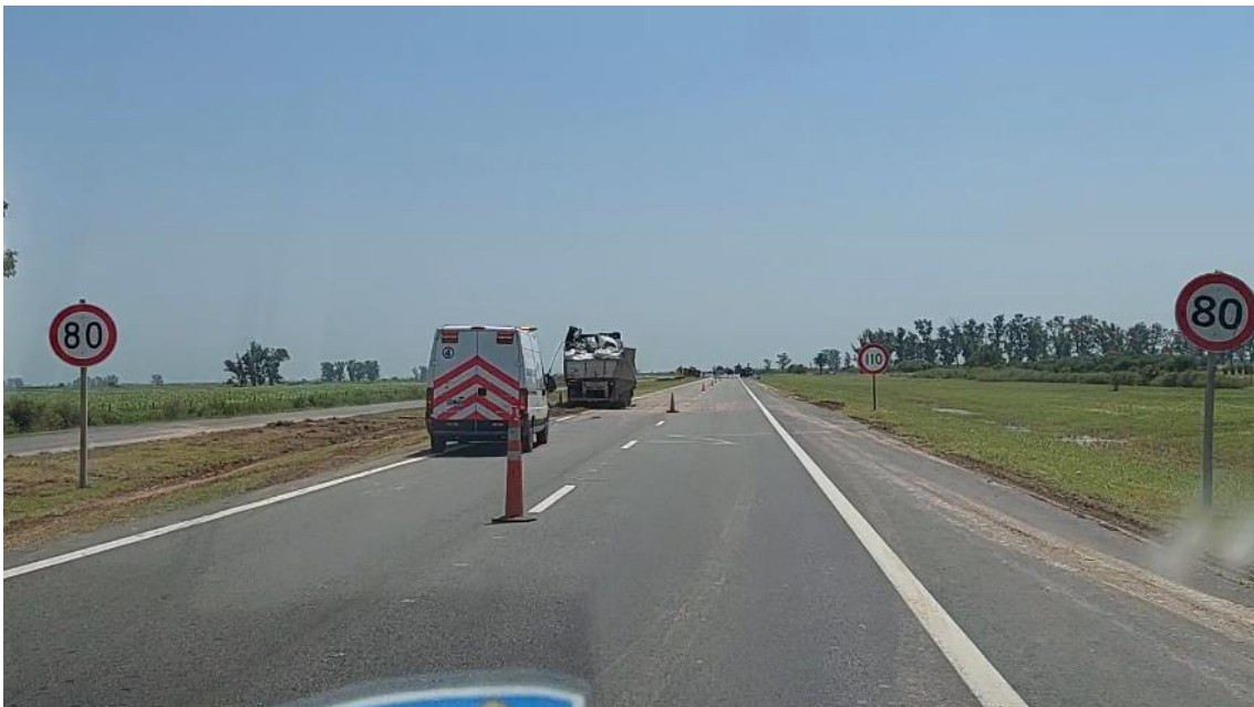
Figura 14. Señalización de velocidad máxima
