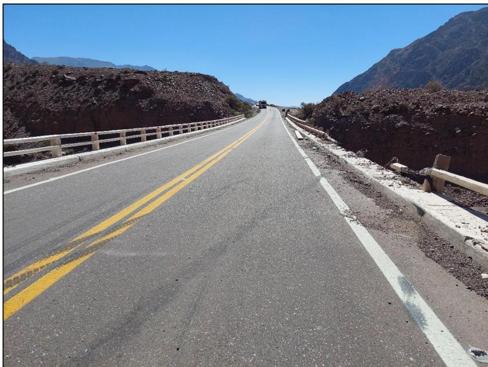
Figura 2. Improntas neumáticas sobre el asfalto y rotura de parapeto oeste del denominado puente Picheuta, mano dirección hacia Mendoza. Fuente: JST, 2022
