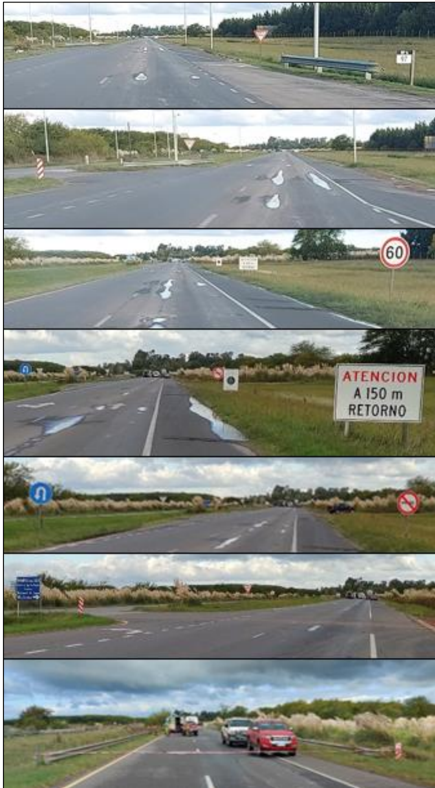
Figura 7. Señalización vertical previa al lugar del suceso. Fuente: JST, 2022.
