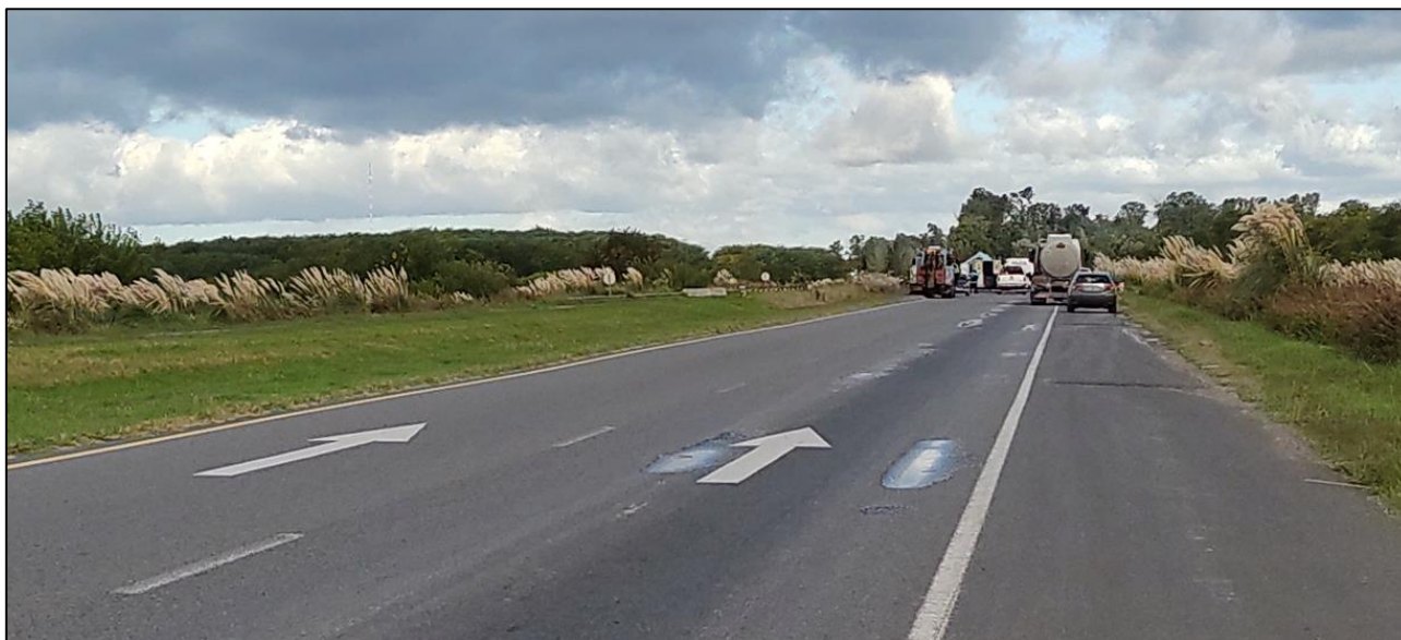
Figura 6. Señalización horizontal previa al lugar del suceso. Fuente: JST, 2022.
