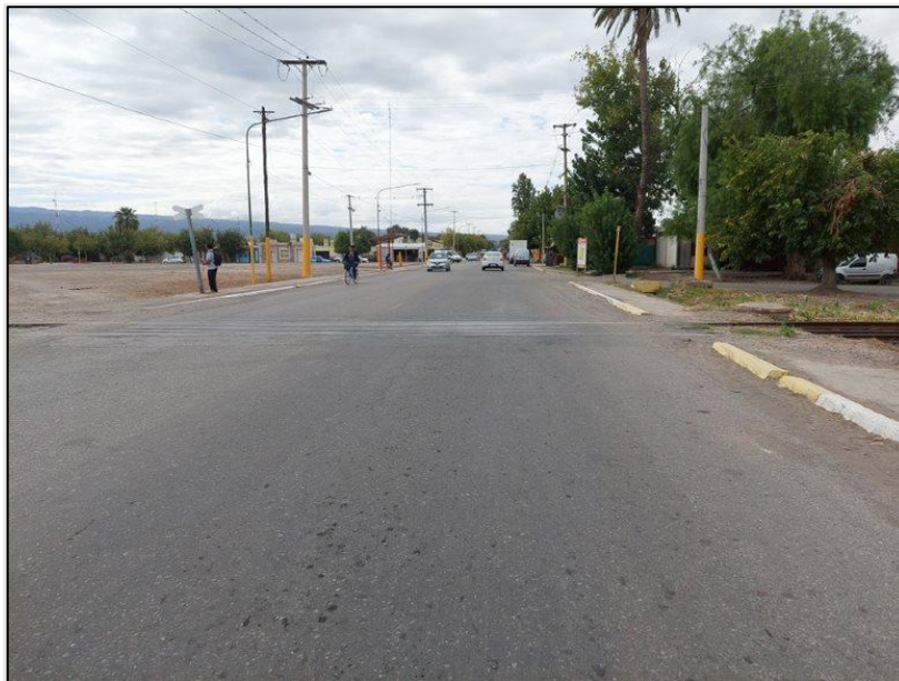
Figura 7. Zona de impacto (vista cardinal hacia el este)
