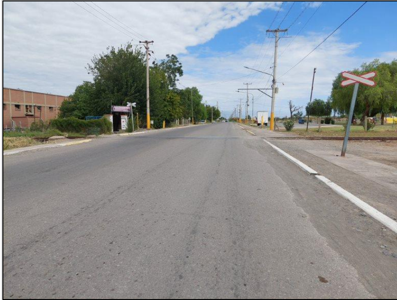
Figura 8. Zona de impacto (vista cardinal hacia el oeste)
