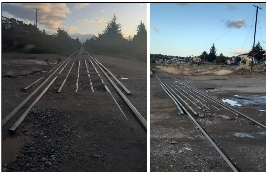
Figura 3. Asfalto en el cruce ferroviario
