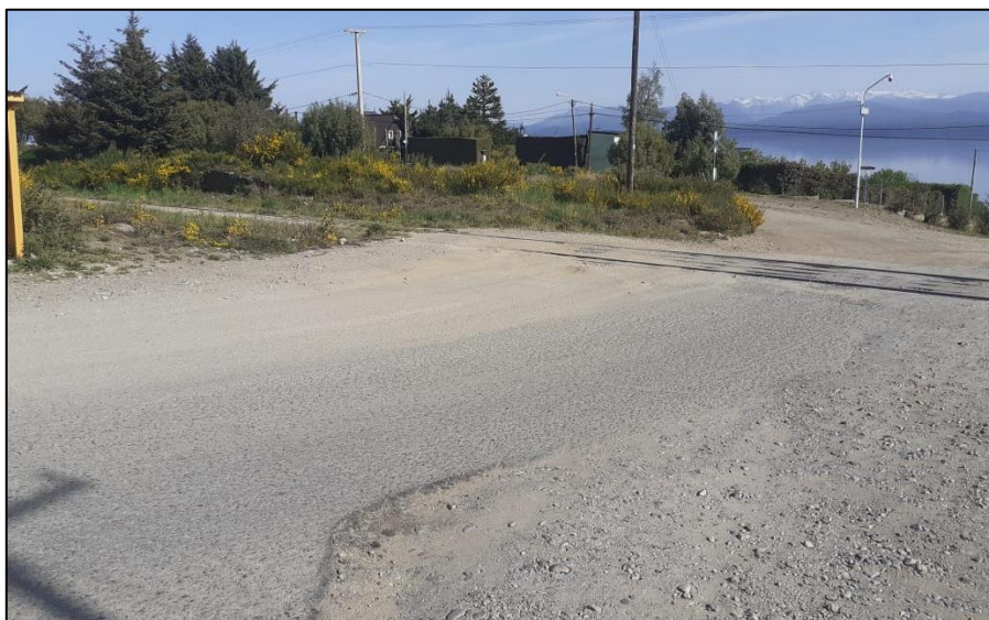
Figura 9. Calzada de asfalto hasta el cruce de las vías. Fuente: relevamiento de campo JST, 2022
