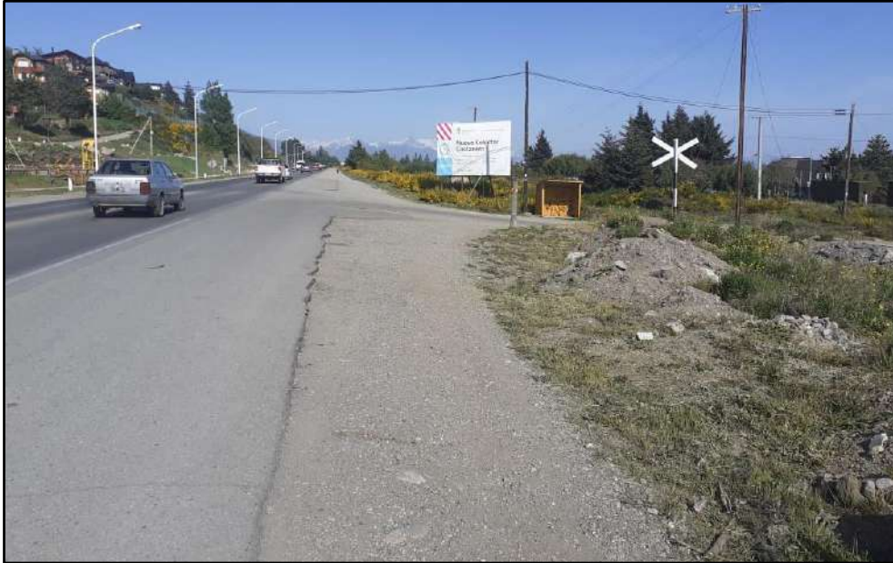
Figura 16. Ruta Provincial 237, metros antes de la intersección con la calle Remolcador Llao Llao
