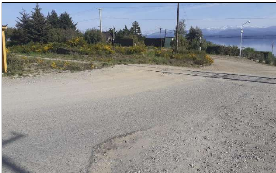
Figura 8. Calzada de asfalto hasta el cruce de las vías
