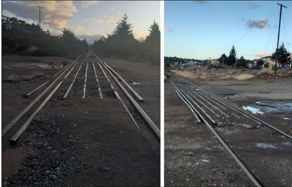
Figura 7. Asfalto en el cruce ferroviario
